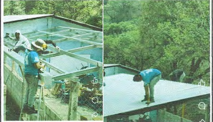
Foto 2: Proceso de mejoramiento de techo de estructura metalica tipo portico con láminas troqueladas calibre 26.
